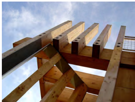
Estructures de fusta dels miradors
